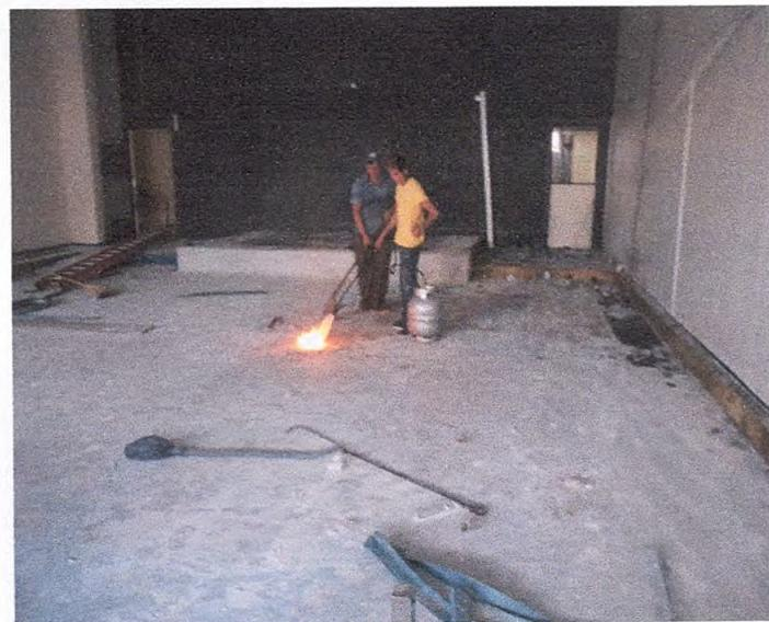
**Após a retirada do piso vinílico foi feita a regularização para colocação do piso.**
