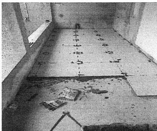
Instalação do revestimento de piso substituídos
