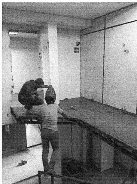
Instalação da ampliação do mezanino
