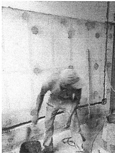
Instalação da rede elétrica no Gab. Presidencial
