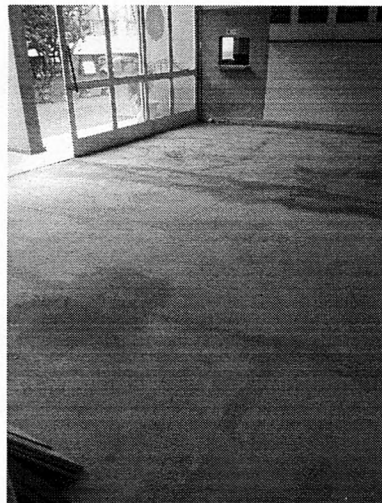
Contrapiso de argamassa
