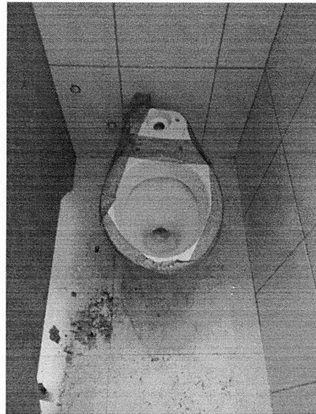
Instalação dos vasos sanitários
