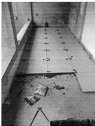
Instalação do piso cerâmico
