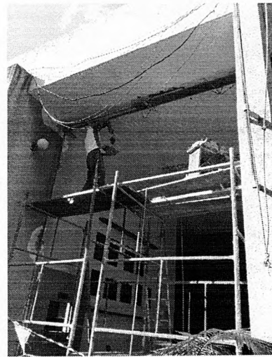
Requadro de vão com utilização de andaime
