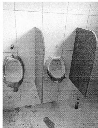
Instalação dos mictórios
