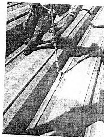
Pintura da cobertura
