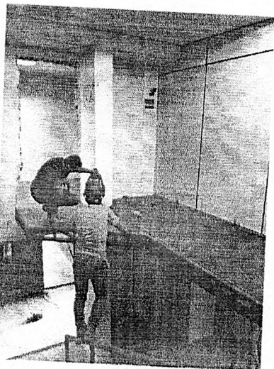
Instalação da ampliação do mezanino
