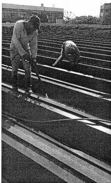
Lixamento e lavagem da cobertura
