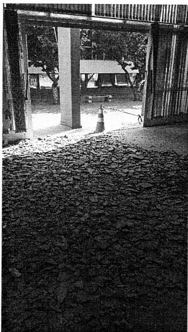
Remoção de piso Cerâmico
