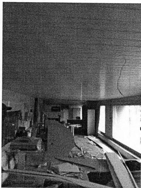
Instalação do Forro em PVC
