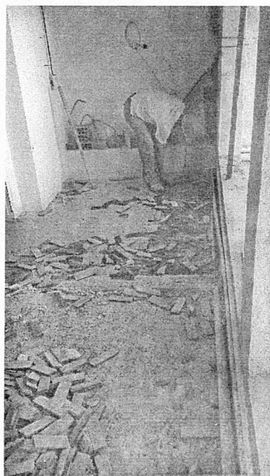
Remoção do Piso de madeira
