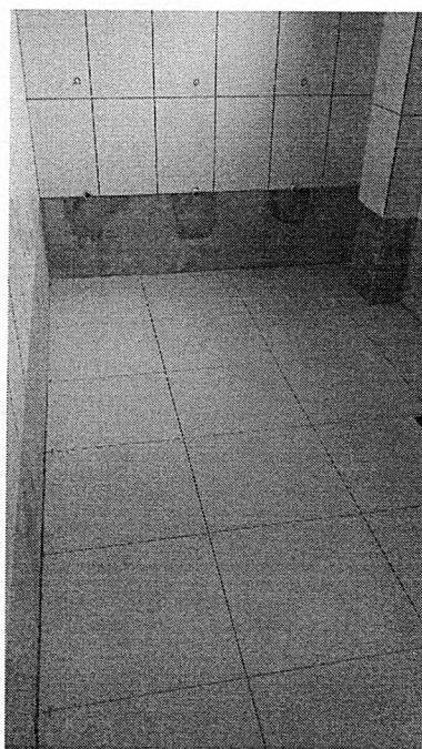
Instalação de revestimento e piso nos banheiros
