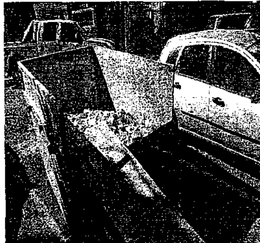
Caçamba contratada para retirada de entulho
