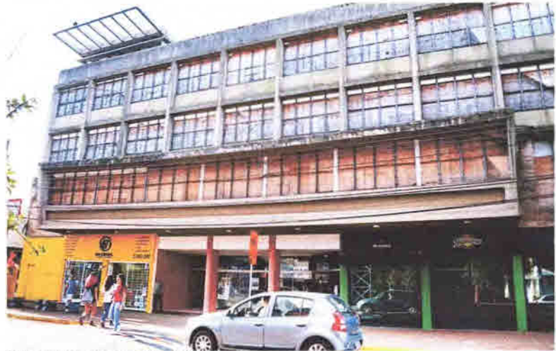
Fachada receberá novas janelas e também será pintada | Foto: Tereza Rodrigo
