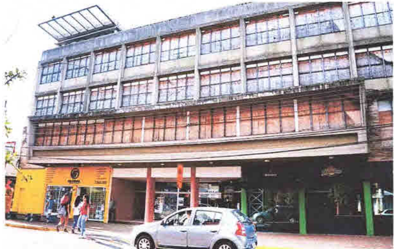
Fachada receberá novas janelas e também será pintada | Foto: Sérgio Rodrigo
